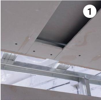
Eseguire un foro nel cartongesso con la larghezza del profilo in vista senza la battentatura.
