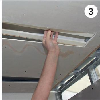
Inserire con cura il profilo nel foro lineare del cartongesso
